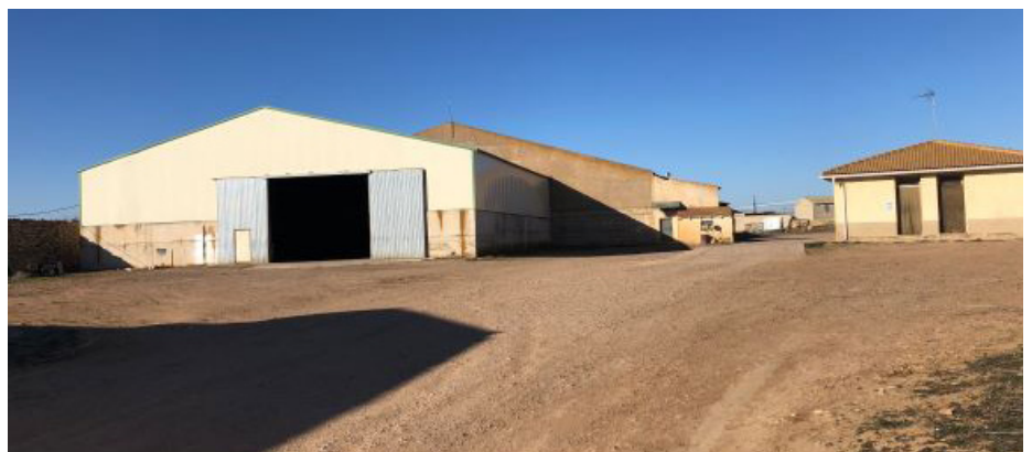
Almacén y oficina
