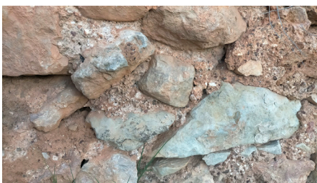
Pared de Zeida: piedras y argamasa de cantos, cal y arena
