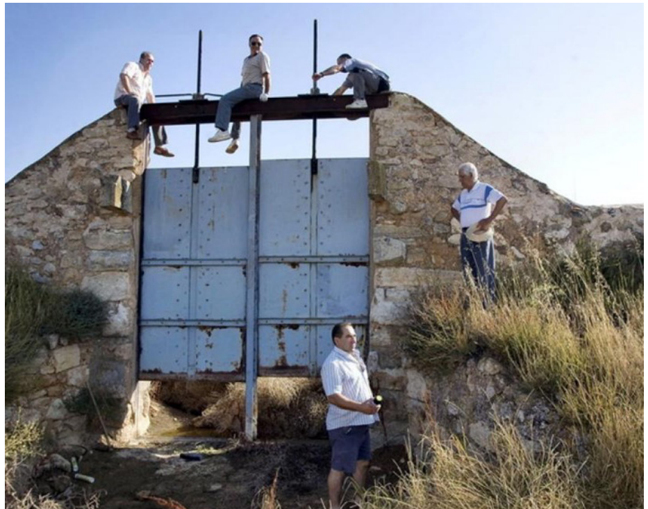
Las compuertas se abren el 15 de agosto, si se ha obtenido cosecha; al siguiente 15 de agosto se cierran
