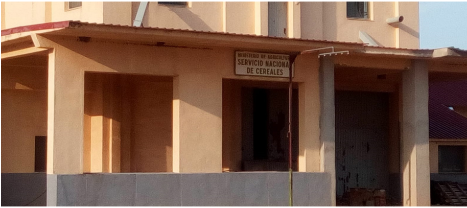
Silo de Used
