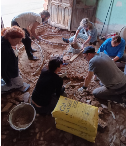
Participantes en el segundo taller de empedrados, restaurando el empedrado del patio de la Casa soleriega de los Ibáñez de Bernabé
