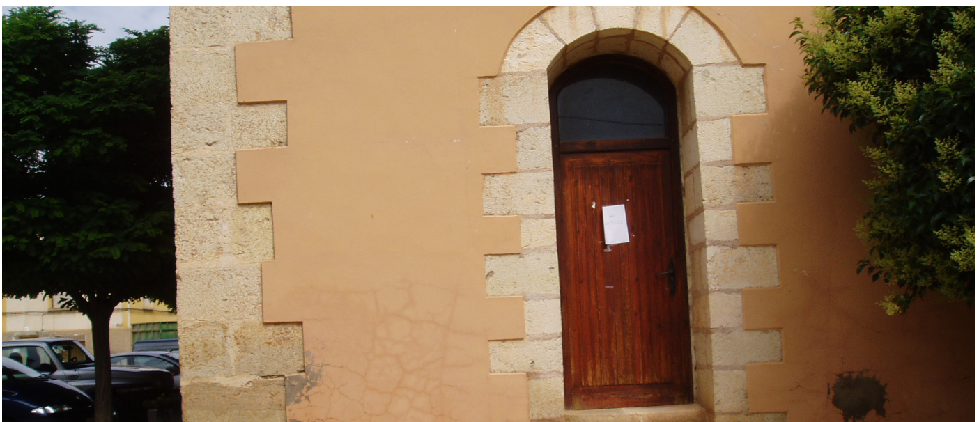
Puerta de la Casa del Concejo, reconstruida en el año 1690, muy próxima a lo que también se llamó la Hermandad de Used.
