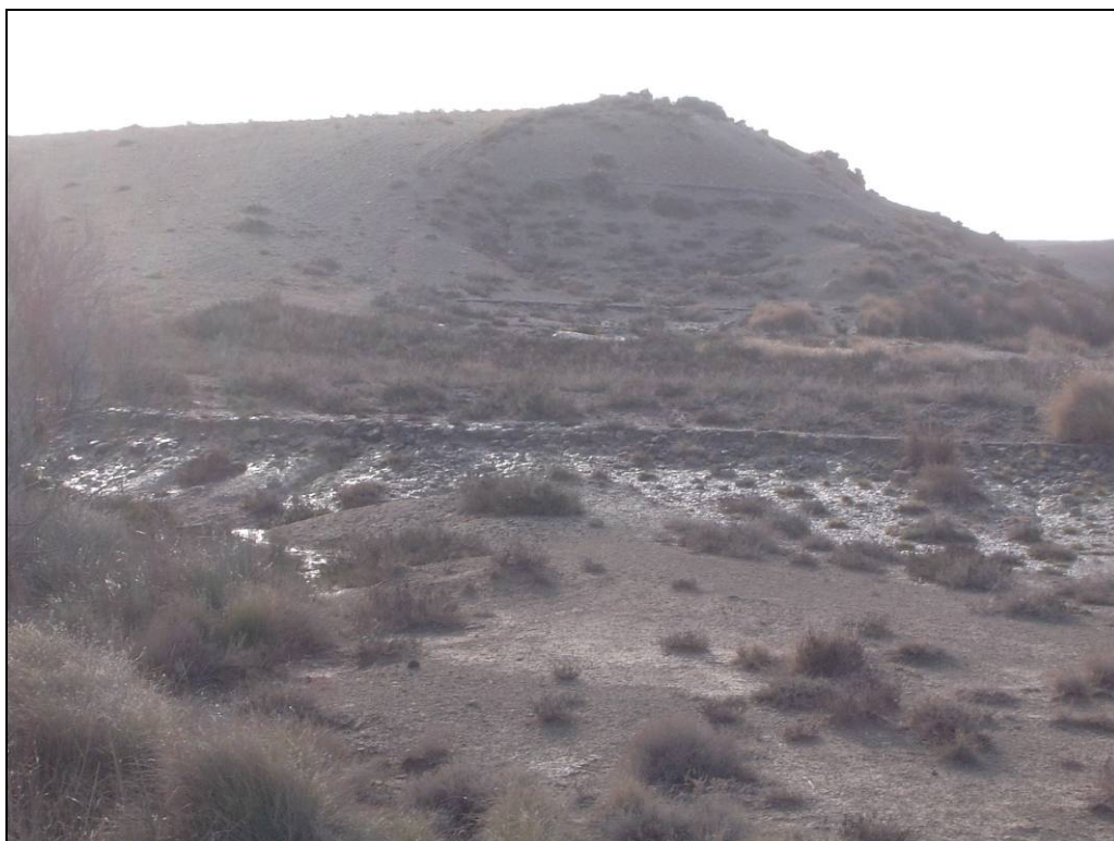
Foto 8. Surgencias del drenaje del riego hacia el barranco.
