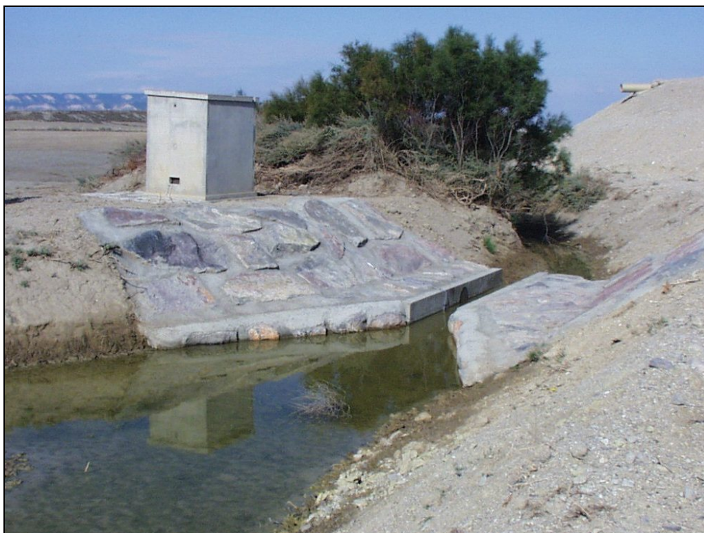
Foto 6. Estación de aforos equipada con limnógrafo electrónico y tomamuestras automático de agua.
